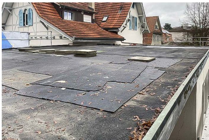
Während der Sanierung
