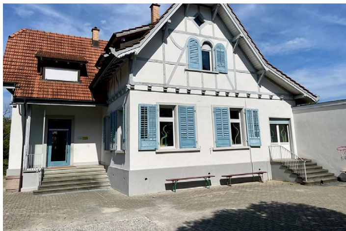
Fassade alt ► Sanierung Abschluss 2025
